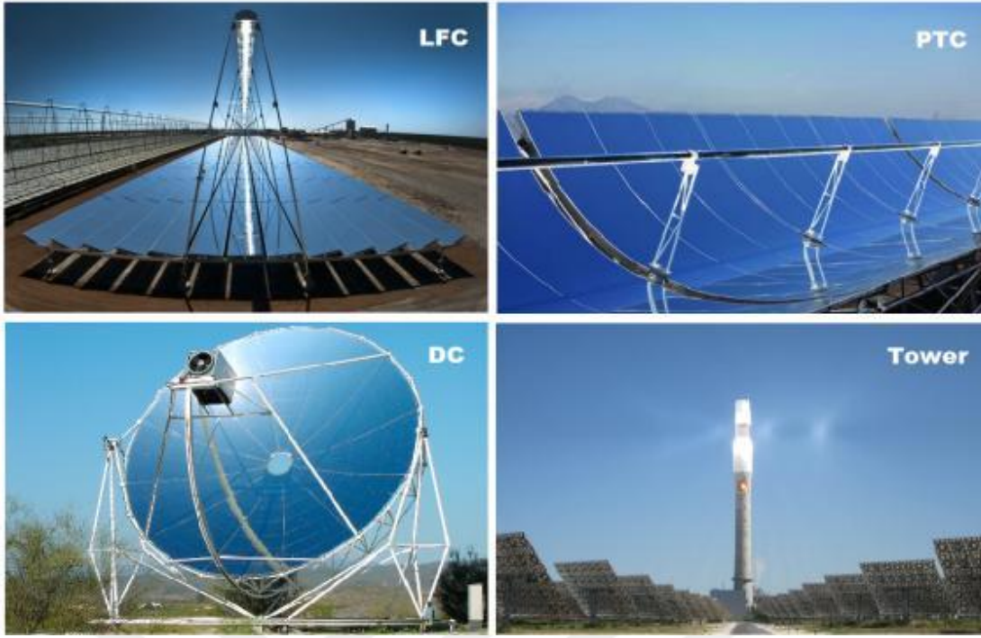
Şekil.3.8 CSP teknolojileri, LFC doğrusal fresnel kollektör, PTC parabolik geçmeli kollektör, DC çanak kollektör, ST güneş kulesi (Mancera vd., 2014)
