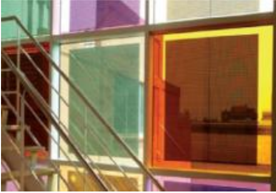
Şekil 4.23. Dış yüzeyine PV panel entegre edilmiş bir yapı (Debbarma, 2017)
