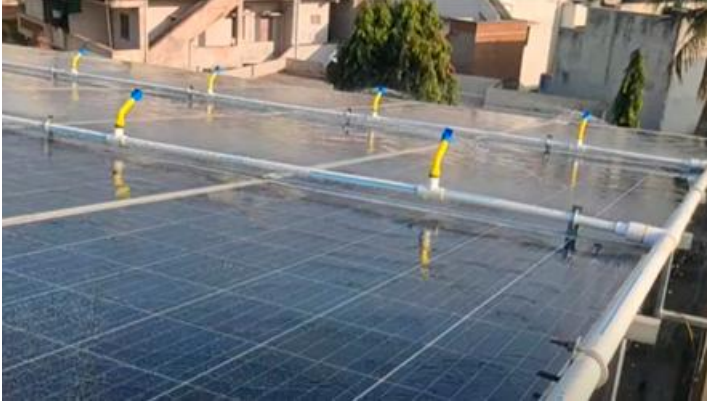
Şekil 4.33. Bir su püskürtmeli temizlik sistemi (Najmi ve Rachid, 2023)
